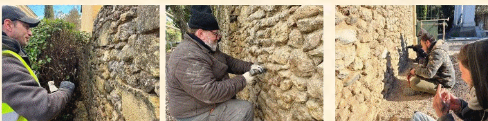
Décroustement des anciens enduits et protection des monuments funéraires
