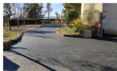
Création d'un nouveau parking au château d'eau [ 16 places ]
