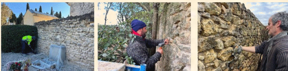
Décroustement des anciens enduits et protection des monuments funéraires
