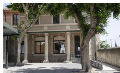
Rénovation énergétique de l'école [ chauffage + éclairages ]
