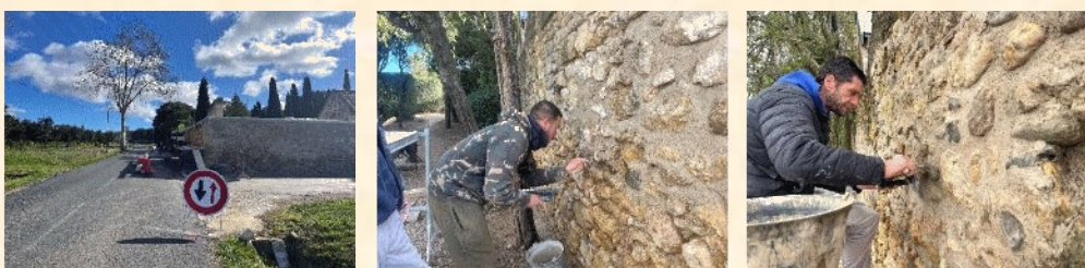
Mise en sécurité du chantier avec arrêté municipal et départemental
