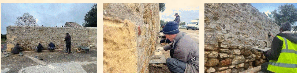
Rejointoiement des murs avec parfois le remplacement de pierres manquantes ou en mauvais état
