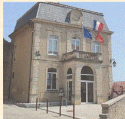
Travaux accessibilité - mairie
