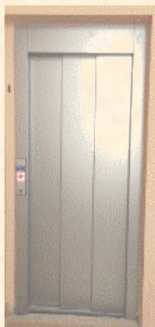
Travaux accessibilité - école
