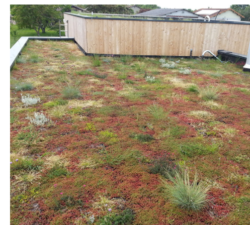
Touiture plate végétalisée
