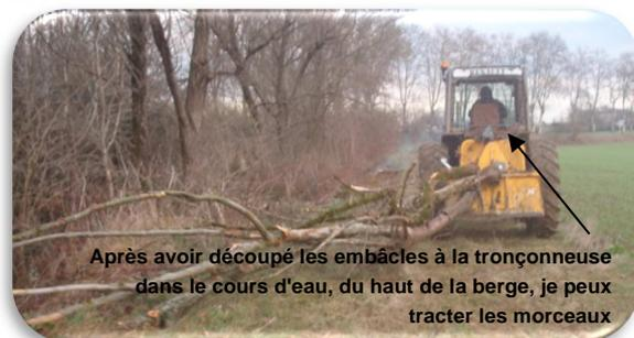
**Déplacer, griffer les atterrissements\*** à condition de **ne pas modifier** le gabarit de la rivière et sans amener un engin motorisé dans le lit\*. Travailler sur la zone émergée uniquement. Leurs déplacements se limitent à ce qui dépasse au-dessus de l'eau.
